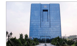
ساختمان بانک مرکزی
