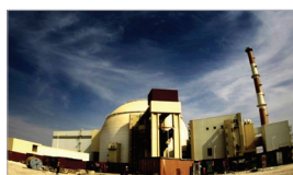
نیروگاه اتمی بوشهر
