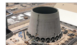
نیروگاه حرارتی طبس
