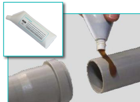
۴ از مایع روان کننده برای جازدن لوله در اتصال استفاده نمایید.
